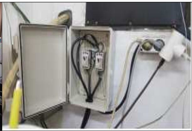
멀티콘센트 과전류차단기 설치
