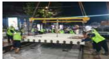
<현장 조립 시공 >
