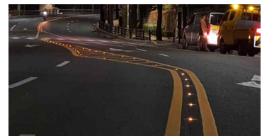
<도로표지병 병행 설치>
