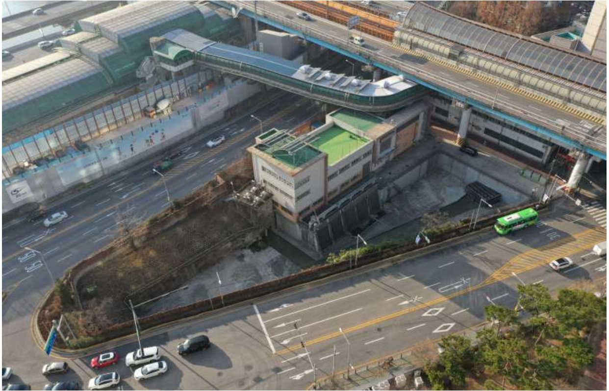
< 옥수유수지 공영주차장 조성 전 현황 >
