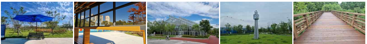
파라솔 설치 파고라 보수 에코식물원 환경정비 시계탑 정비 보도육교 보수정비
