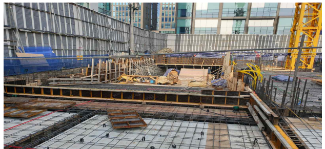
〈4세대 지역난방 실증부지 건설 현장〉
