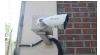
< CCTV 교 체 >
