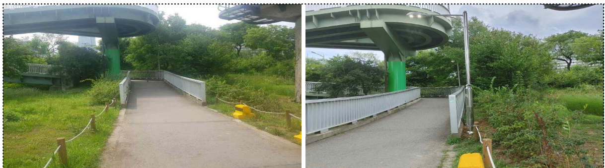
[설치 전] 잠실대교 자전거길 조명 신설 [설치 후]
