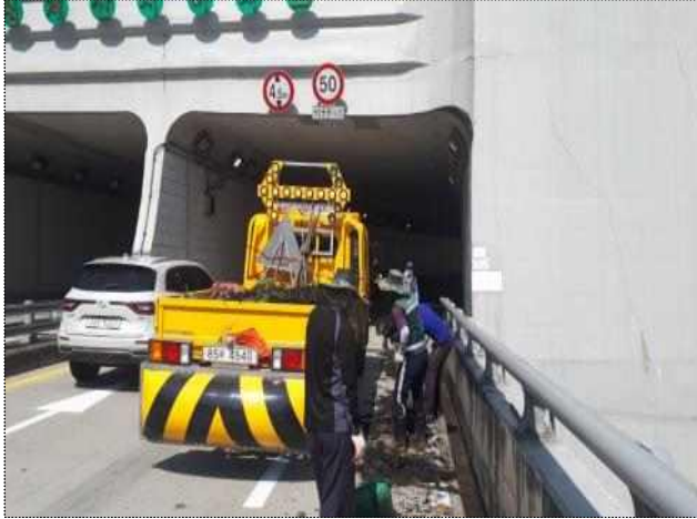
청계산 지하차도 배수로 청소
