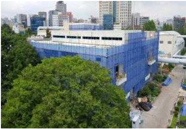
건조시설(증설) 설치 건물 (연면적 3,260㎡)
