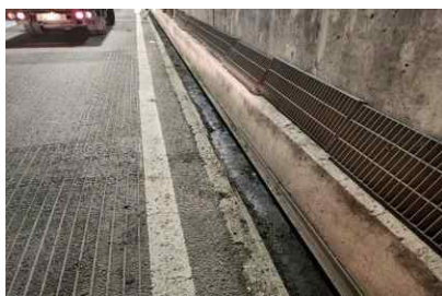
〈고척2지하차도 배수로 준설〉
