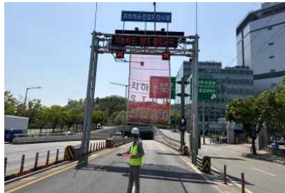
〈청계산지하차도 진입차단시설 점검〉
